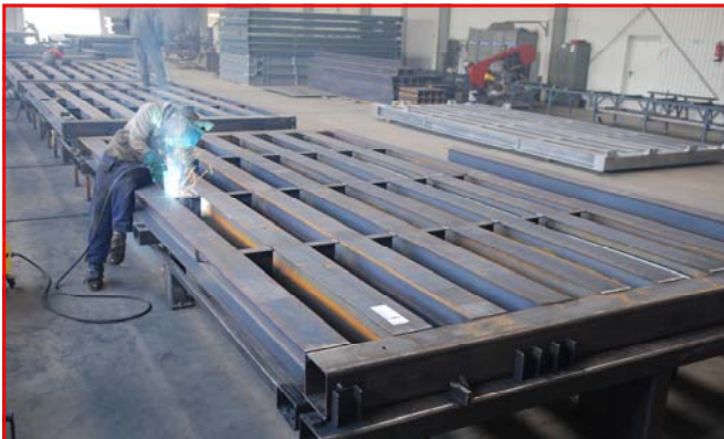
1. Spawanie konstrukcji nośnej pomostu wagi
