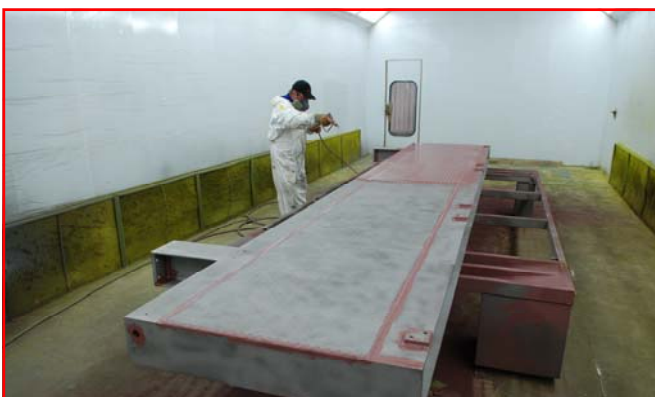
7. Malowanie natryskiem bezpowietrzną farbą podkładową
